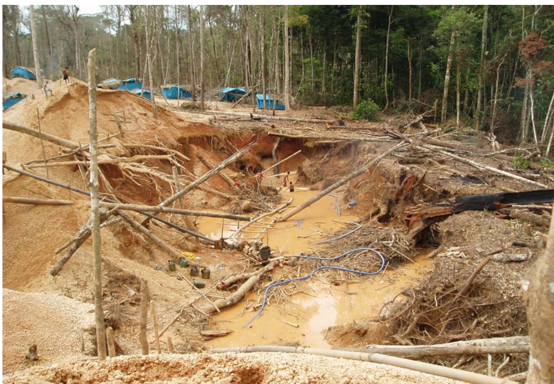
La minería destruye el bosque, con motores y mangueras incursionan en el monte virgen
